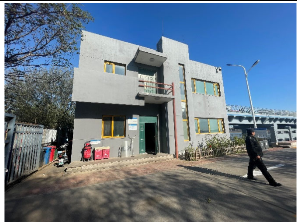
拦河闸西管理用房
