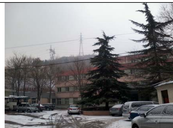
◆3 山东电建一公司宿舍楼
