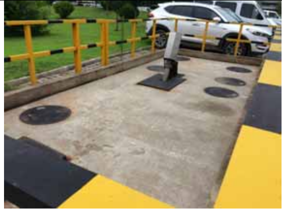
园区内现有污水站现状（本次依托工程）
