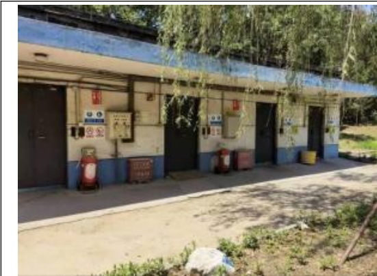
化学品库（左 2 间）及 危险废物暂存间（右 2 间）
